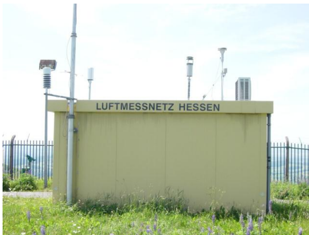
Abbildung 24: LUG-Station Wasserkuppe – Messcontainer.
